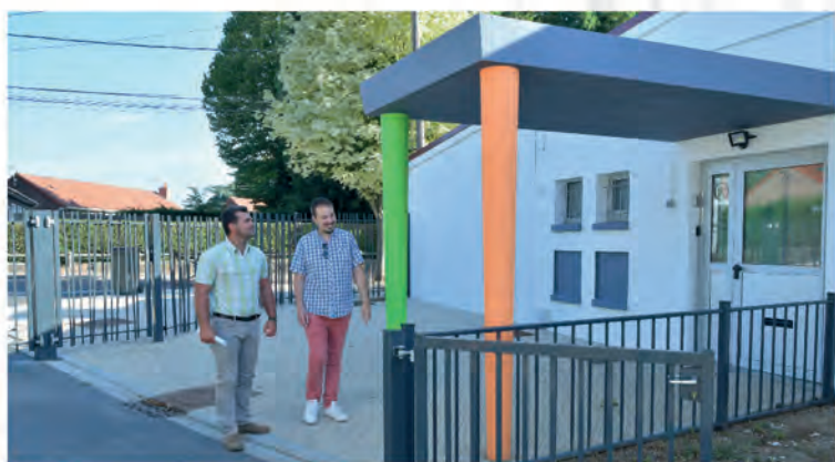
Travaux de peinture de la façade de l'école Dubreucq.
