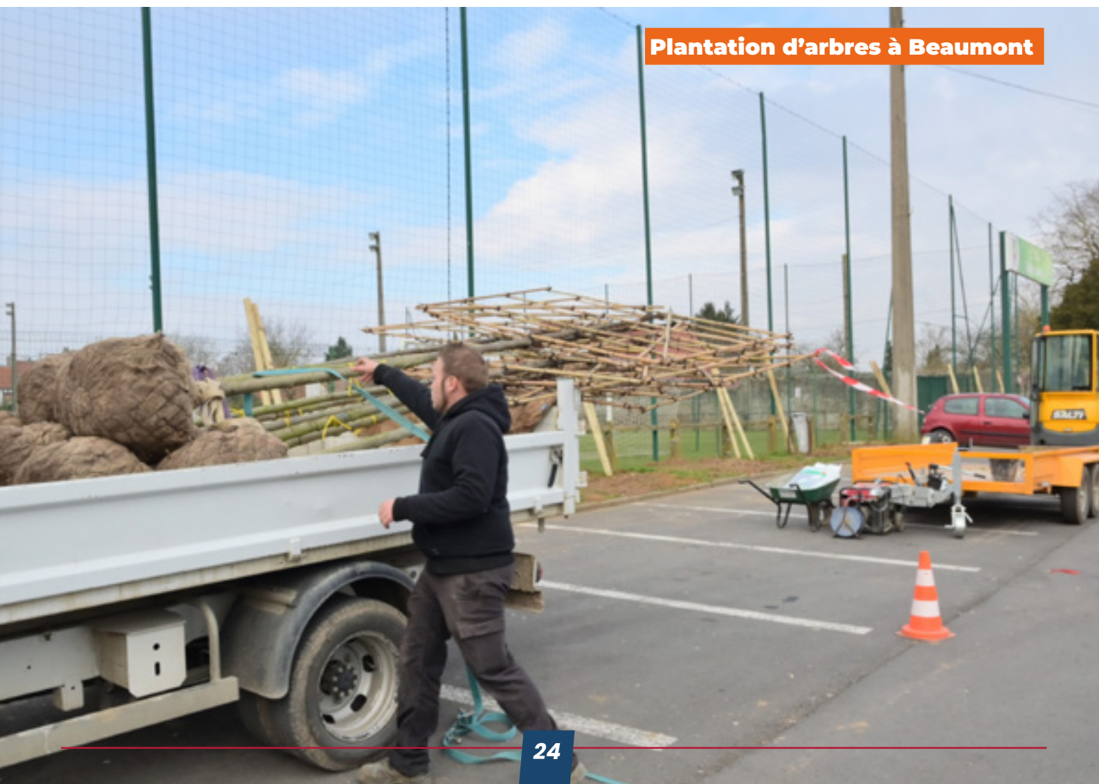
Poursuite des travaux à l'îlot Carnot
